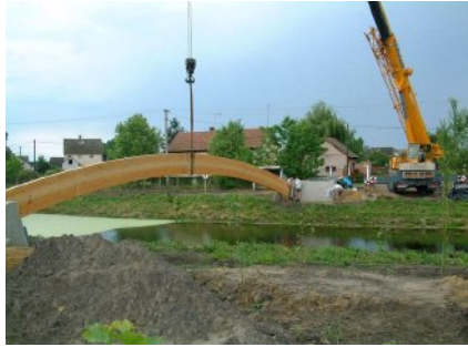
Épül a szigetvári (91. fejezet) ( Lignum ) és a nyírlugosi híd (93. fejezet) ( faepites )
