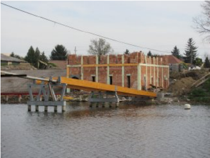
A szarvasi fahíd (123. fejezet) kivitelezése 2010 őszén
