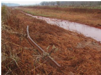
A kolontári gyaloghíd (53. fejezet) főtartója és a híd maradványai a töltésen
