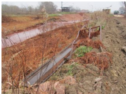
A kolontári gyaloghíd (53. fejezet) főtartója és a híd maradványai a töltésen
