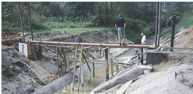
A hetvehelyi mérőhid (52. fejezet) építés közben (DDKÖVÍZIG)
