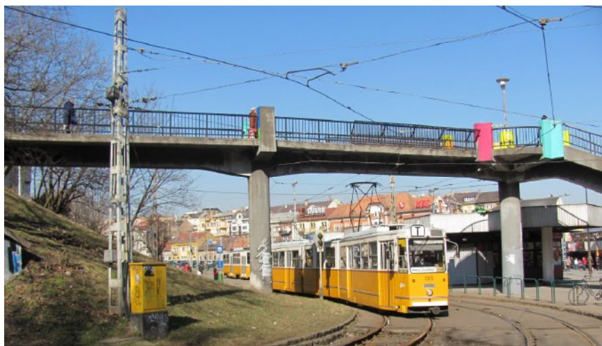
További példák: HÉV feletti híd a Nemzeti Színháznál (fent), Moszkva téri villamos feletti műtárgy (lent)
